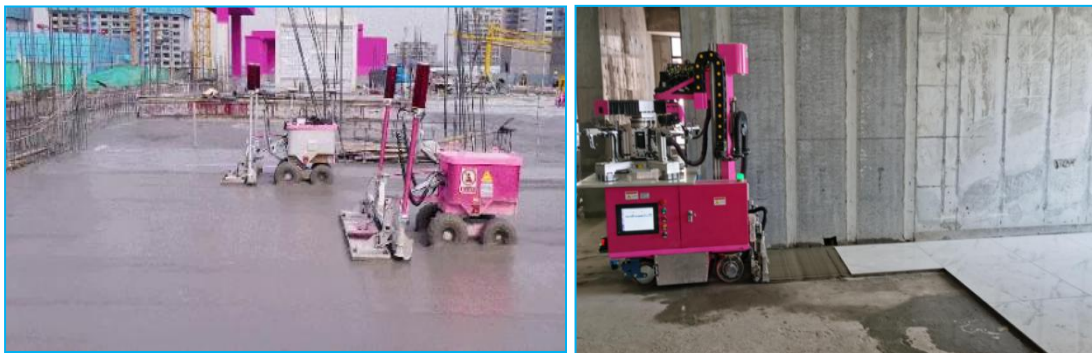
图 5-6 智能建造机器人施工应用场景
