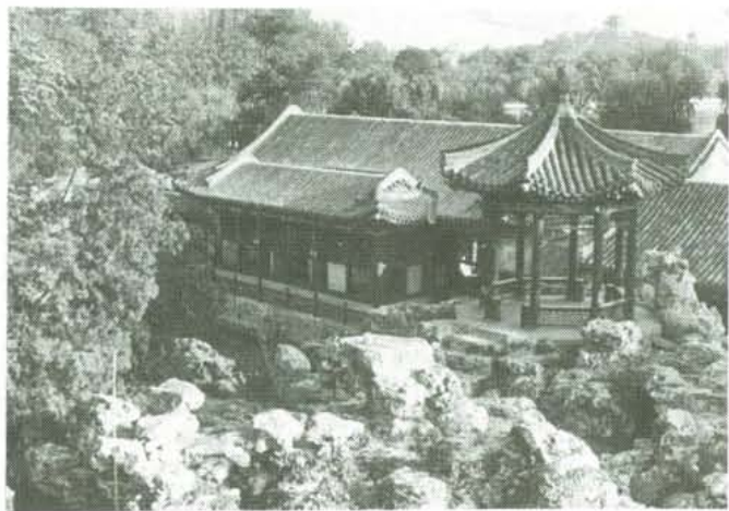
自高处俯视六角亭及静心斋
