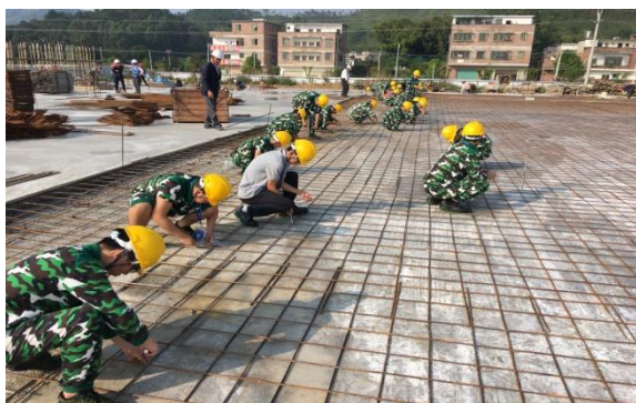
学院体育馆底板钢筋绑扎
