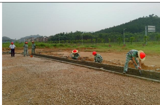
校内实训基地现场砌筑实训
