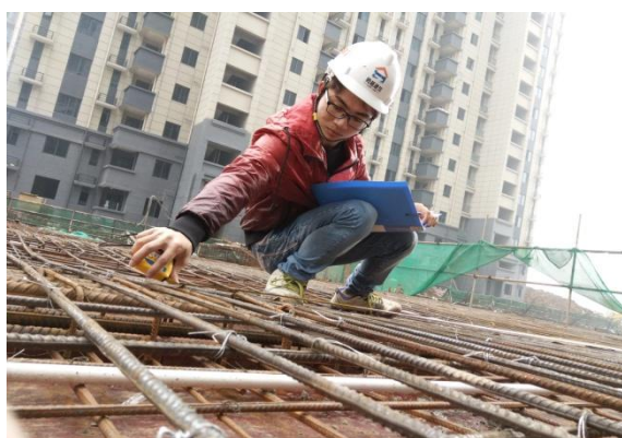
钟健文同学现场验收钢筋
