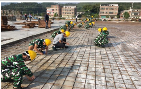
学院体育馆底板钢筋绑扎
