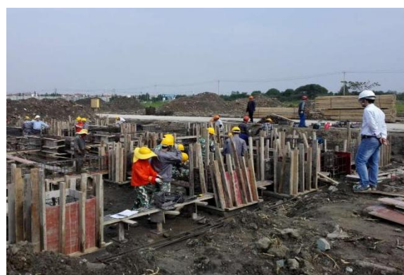
江苏泰州碧桂园林湖郡住宅基础施工
