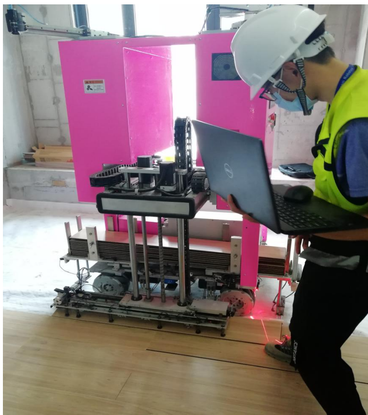
图 1 顺德碧桂园凤桐花园项目使用的木地板安装机器人
